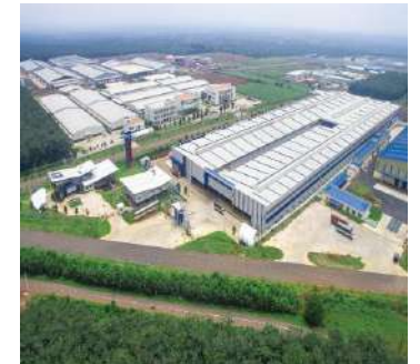
Nhà máy Panasonic Thăng Long
